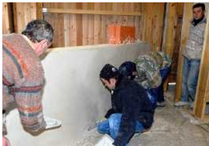
Les éco-artisans sont agréés après une formation à la fois théorique et pratique. Ici la pose de cloisons en chanvre.
